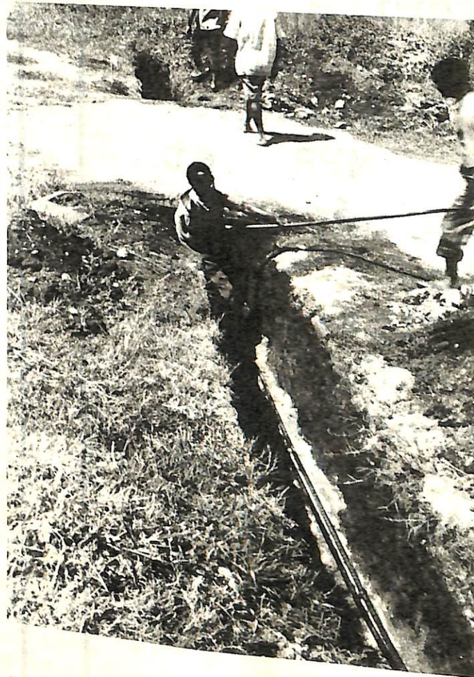
Le câblage électrique a été restauré à 100 %
