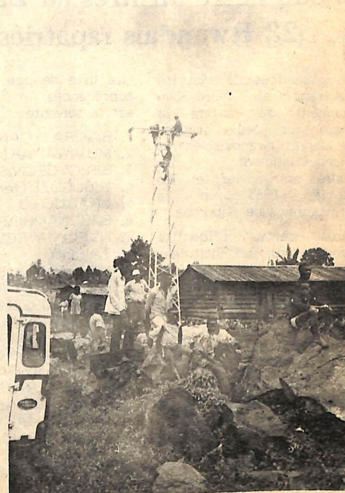
Montage des câbles de la ligne 15 KV
